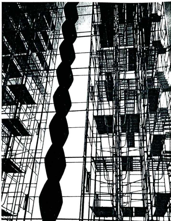
Brancusi. «La Colonne de l'infini». Chantier de restauration à Targu-Jiu (Roumanie)
